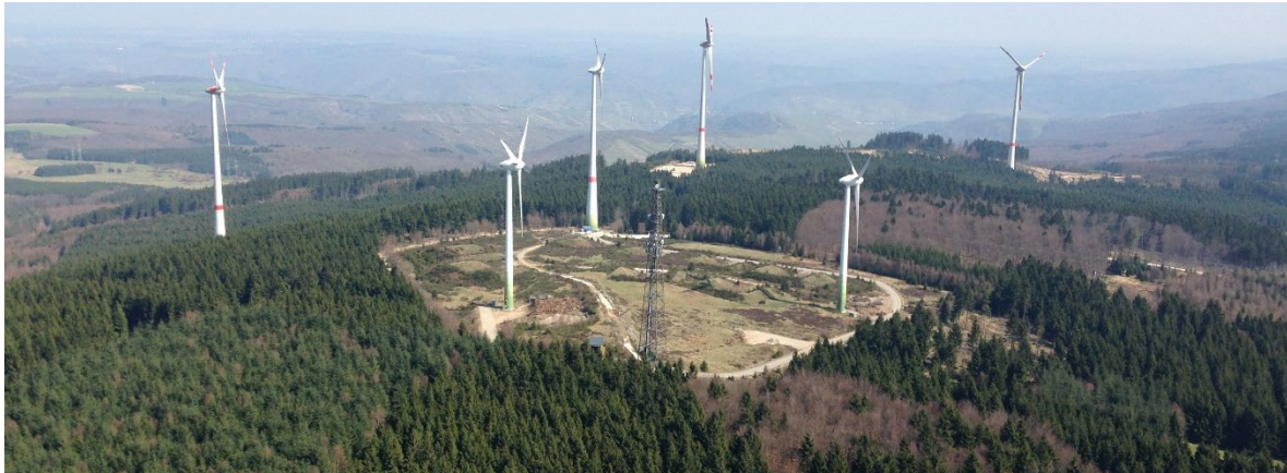
Abbildung 29: Windpark Kandrich auf ehemals militärisch genutztem Standort im Landkreis Bad Kreuznach (Rheinland-Pfalz)
