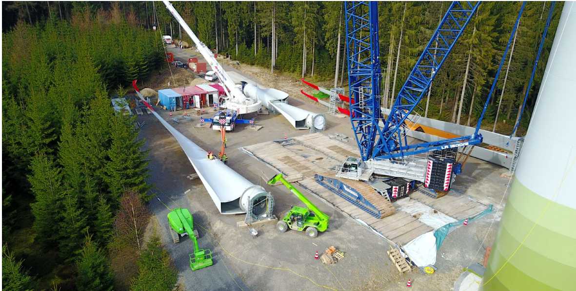
Abbildung 5: Kranstellfläche und temporäre Montageflächen während des Aufbaus einer Windenergieanlage
